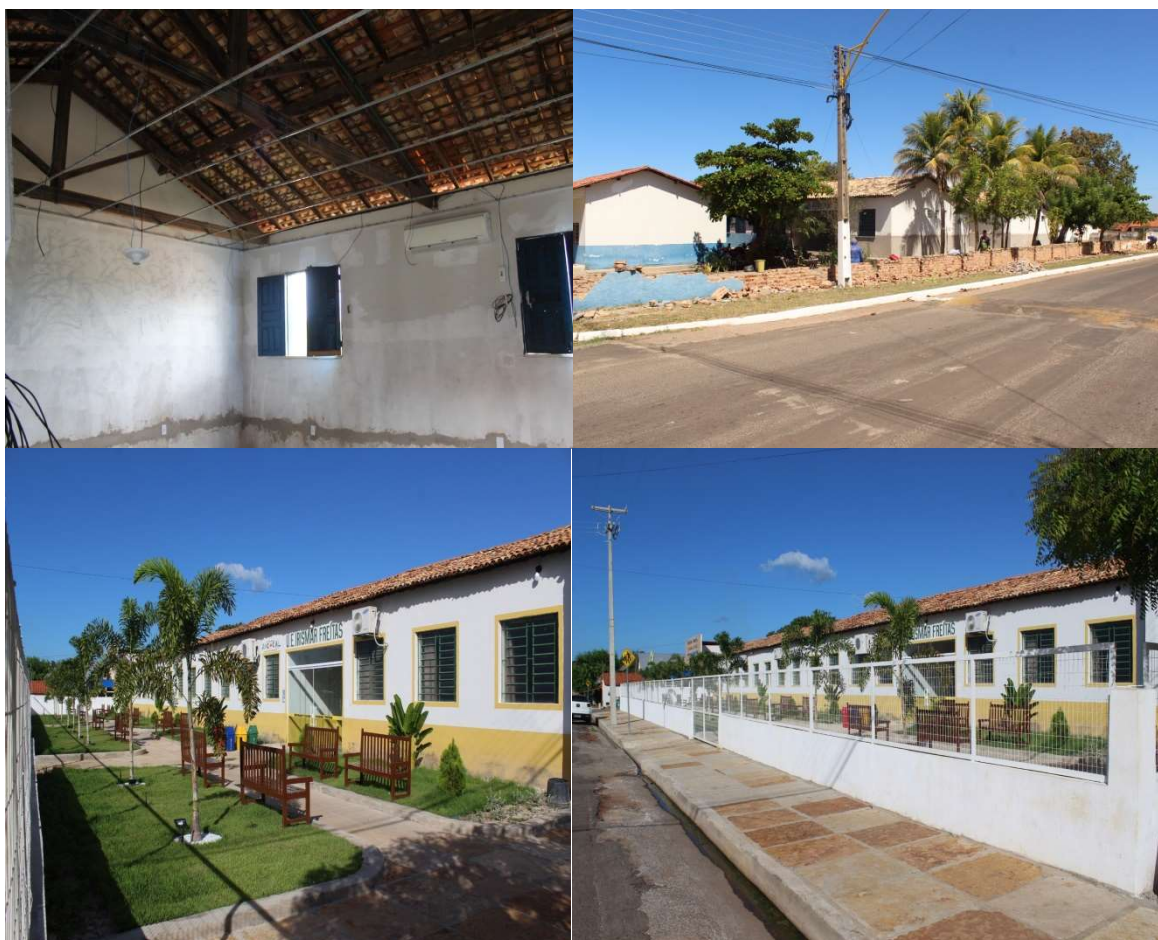
Foto 27 – Reforma das Unidades Escolares da Rede Municipal.
