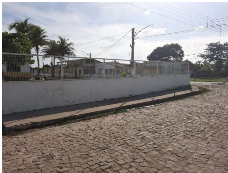
Foto 29 – Reforma da U. E. Francelino Pereira.
